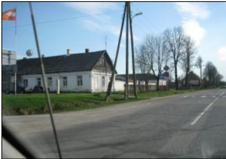
Tiesiant traktą pakelėse buvo statomos diližanų stotys, pusstotės, kelio prižiūrėtojų pastatai.
