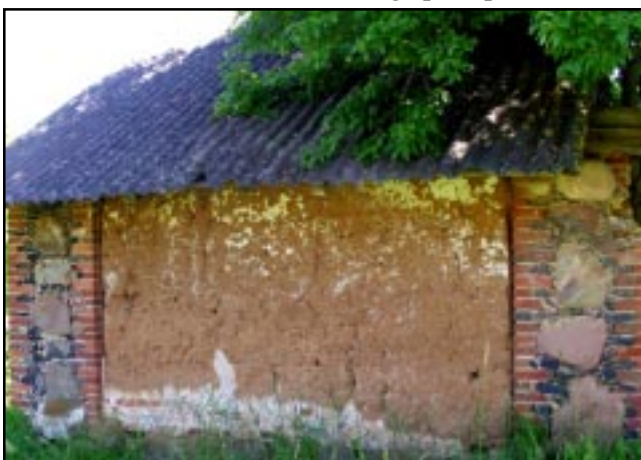
Noliškio dvaro ūkio pastato šiaurės vakarų fasado dalis.
